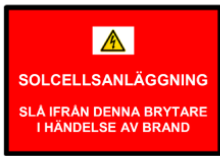
Figur 2 Informationsskylt vid tryckknapp för manövrering av brandmansbrytare.
